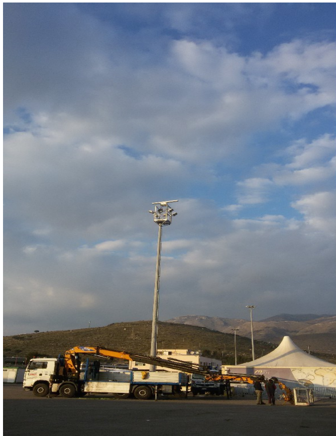
Fig.5 Radar X-band installato sulla torre faro
