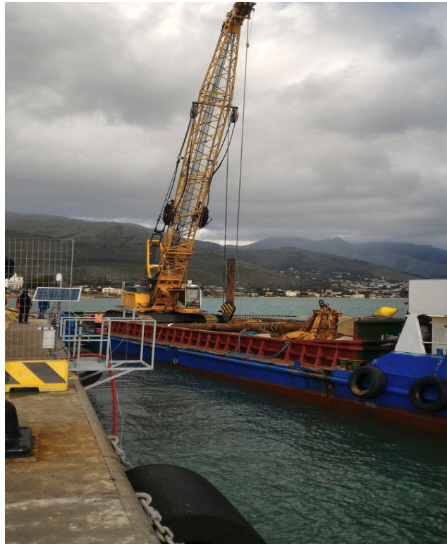
Fig.22 A sinistra pontone durante le operazioni di dragaggio
